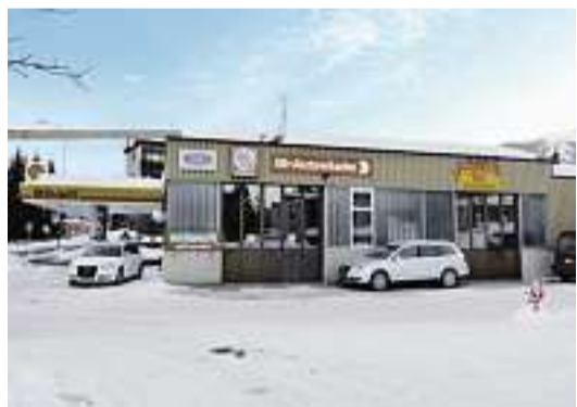
Das gegenwärtige «Gesicht» der Sportplatzgarage.
